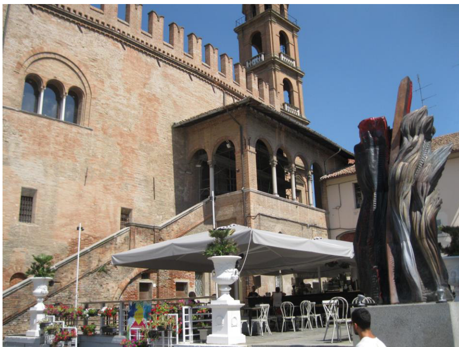
Foto 4 : loggia da ristrutturare adiacente al Salone dell'Arengo
