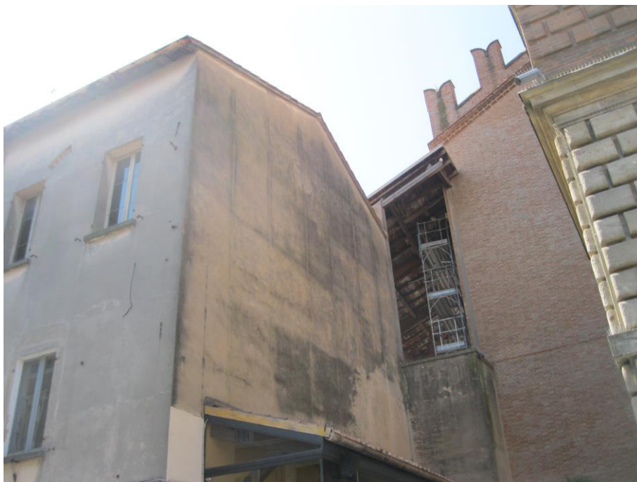
Foto 2 : lato corto ex albergo Corona prospiciente la Torre Civica
